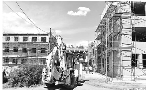
стем водоснабжения и канализации. В помещениях поликлиники и корпуса № 2 ведутся электромонтажные работы и устройство перегородок из гипсокартонного листа.
