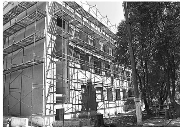
(Чеченская Республика) по заказу Ямало-Ненецкого автономного округа выполняется устройство стяжки, утепление фасада, прокладка инженерных сетей, устройство кровли.
