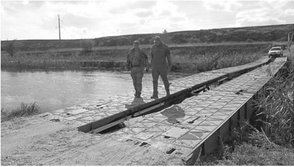
Вблизи села Павлополь специалистами МЧС ДНР был установлен понтонный мост через реку Кальмиус как временная мера до ремонта основного моста, соединяющего оба берега реки.
